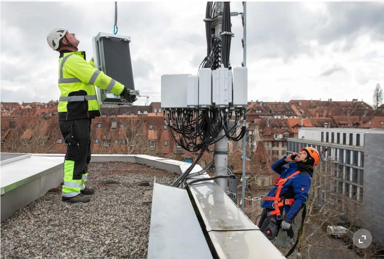
Spezialisten der Swisscom installieren über den Dächern von Bern Sendeantennen für den schnellen Mobilfunkstandard 5G.
